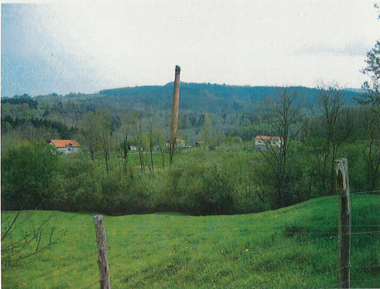
Vista general del emplazamiento
